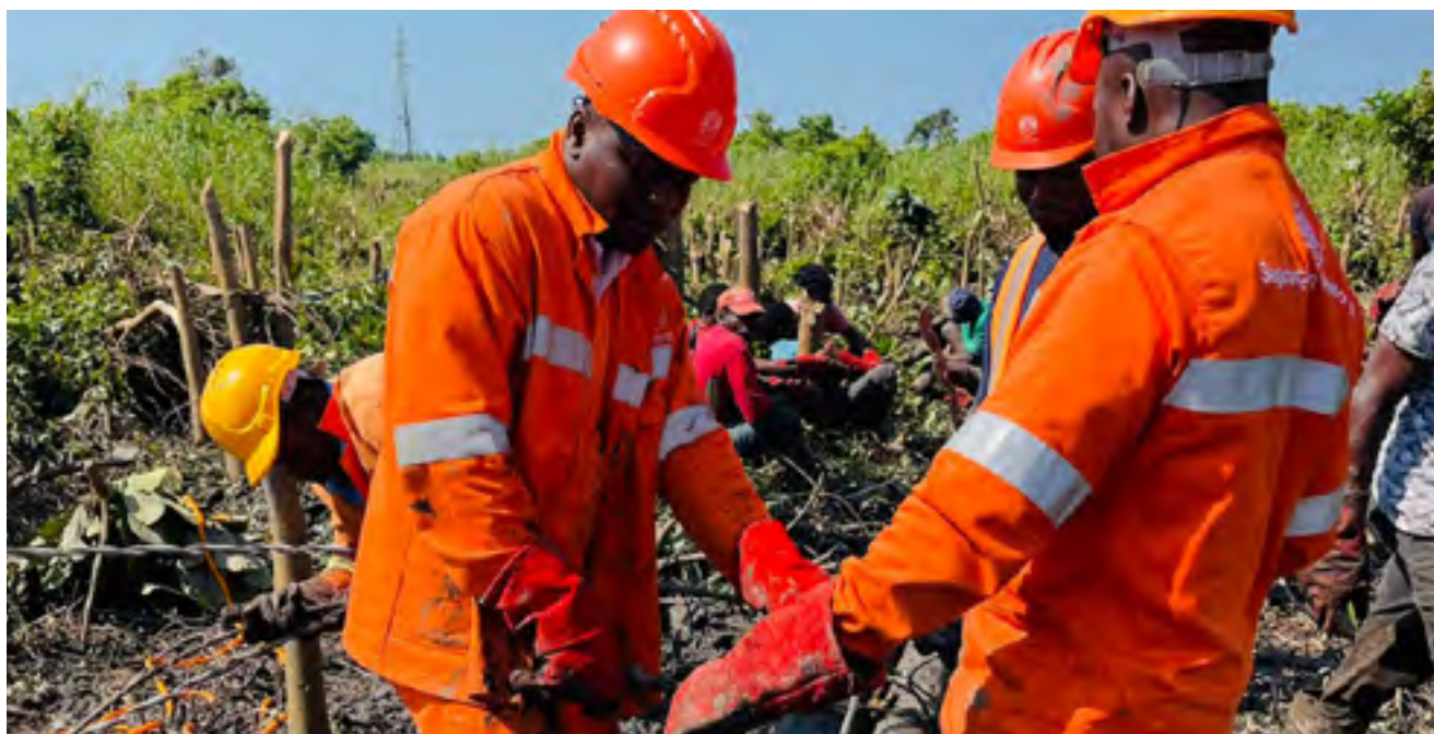
A EDM restaura energia na Vila de Chinde, após queda de pórtico no Rio Zambeze, na Província da Zambézia - Agosto de 2022.
